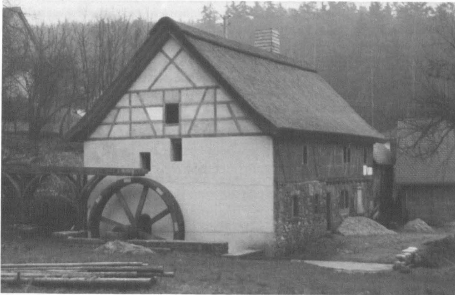
Giebelseite mit Wasserrad und Wasserzulauf-Brücke
