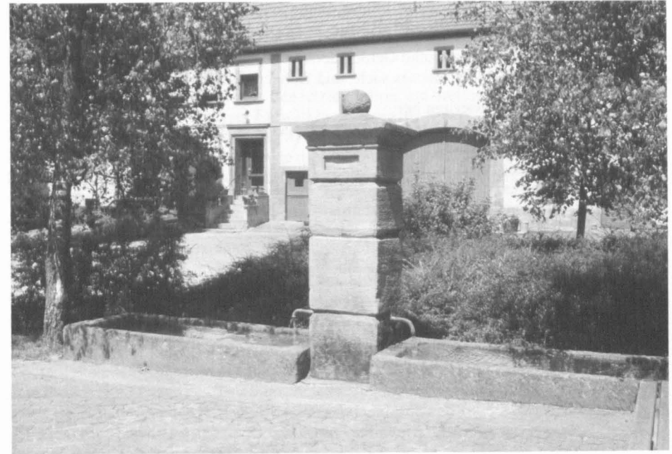
Laufbrunnen, Ortsmitte Dörrenbach
