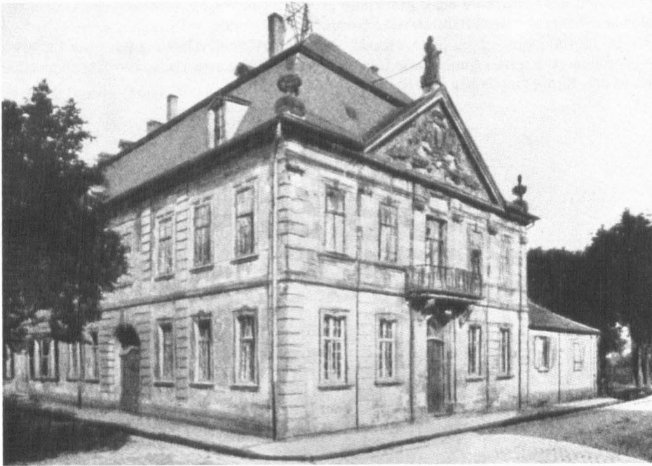
Abb. 6 J.C.L. Hault, Ehemaliges Waisenhaus in Blieskastel 1774/75 (heute Rathaus), 1782 erweitert
