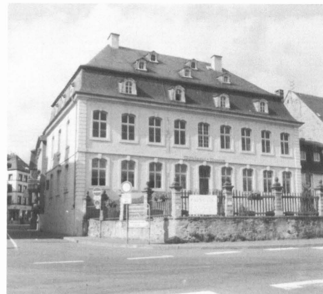
Abb 5 J.C.L. Hault, Böcking'sches Familienhaus in Traben-Trarbach von 1760 (Zustand 1988)
