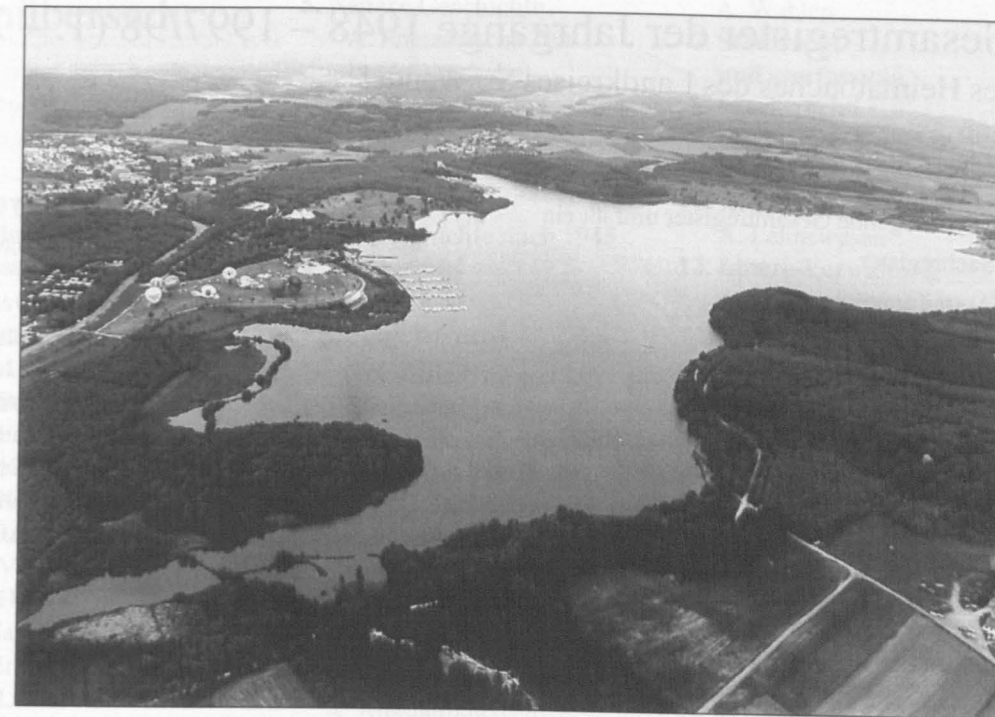
Am Bostalsee wird investiert – zum ersten in ein auf mehrere Jahre angelegtes Ertüchtigungsprogramm für den Staudamm, zum zweiten in ein neues Sanitärgebäude auf dem Campingplatz
