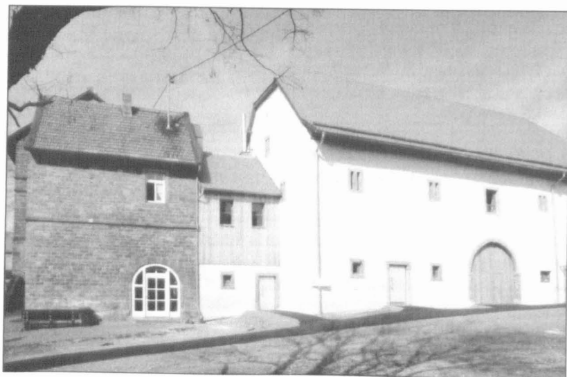
Heute: Die zum modernen Dorfgemeinschaftsbaus umgebaute Scheune
