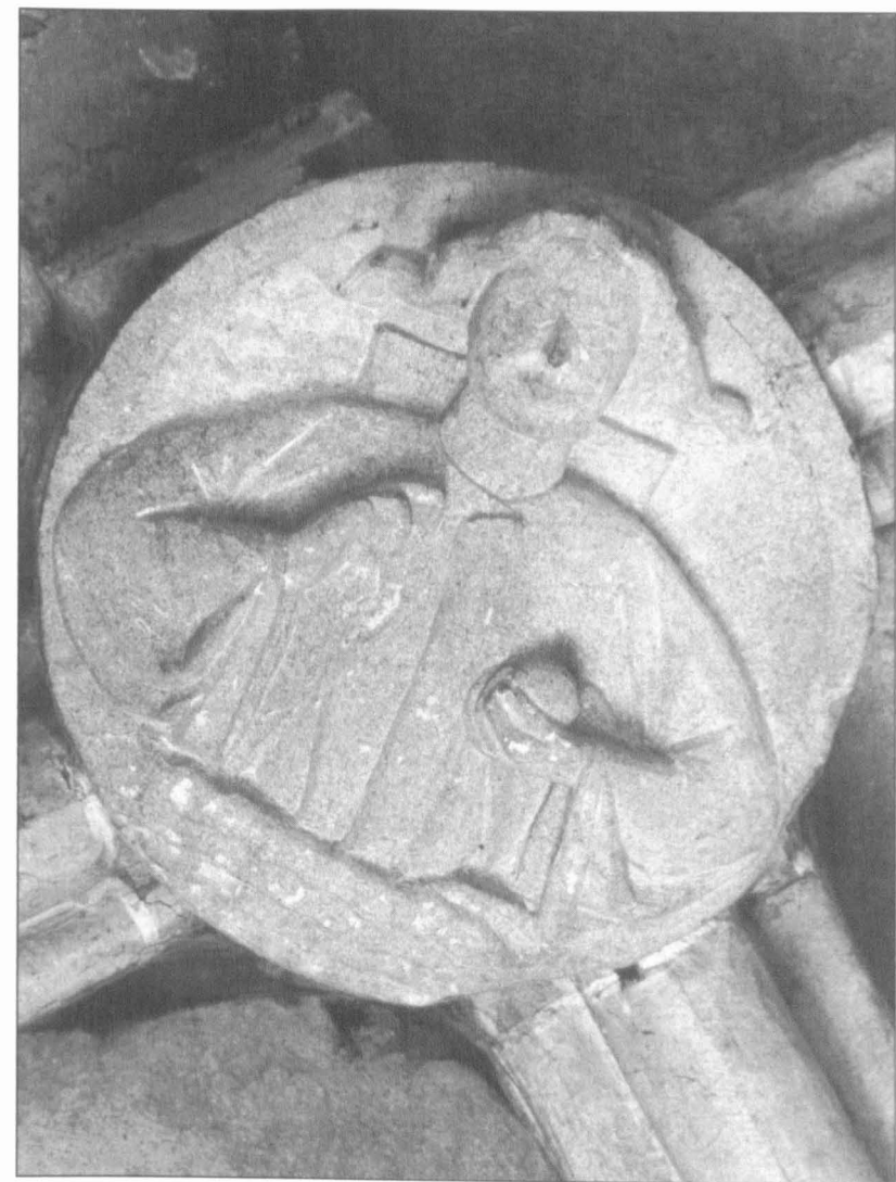
Nordseitenschiff, erneuerter Schlussstein
