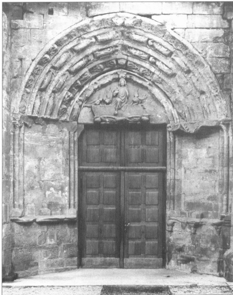
Nordportal vor der Instandsetzung
