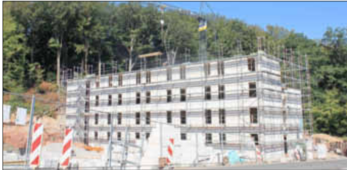
Im April wurde der Grundstein zu den drei Gebäuden gelegt. Inzwischen steht der Rohbau vor der Fertigstellung. Foto: pdk
