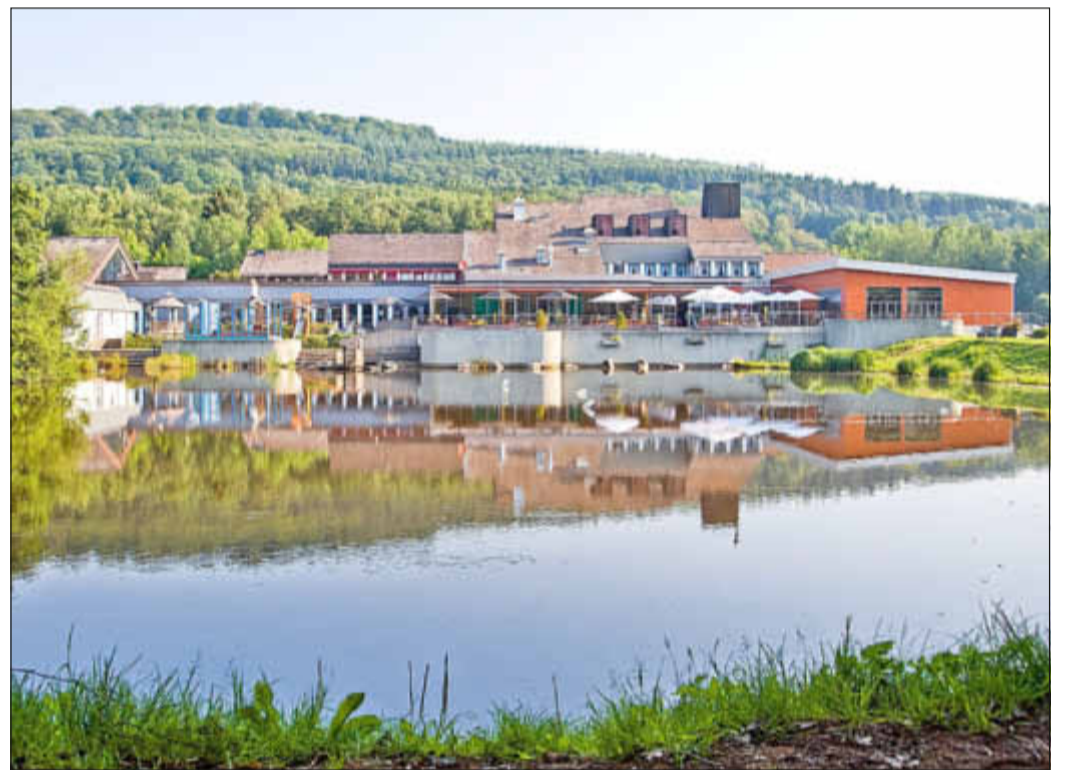
Das Zentralgebäude des Parks im Hambachtal. Foto: Roompot
